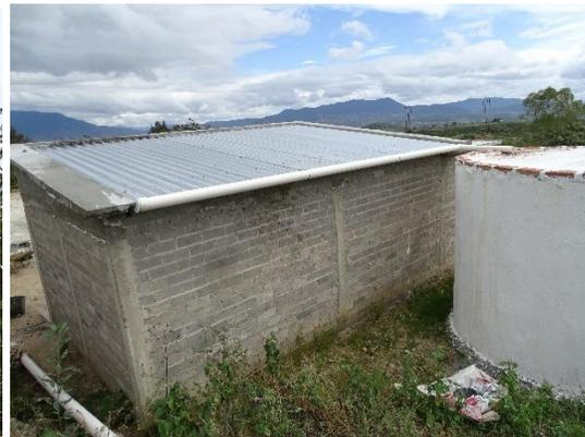
Anexo 5. Resultado final, las canaletas conectadas de los techos y estos a la cisterna para la captación de agua pluvial.
