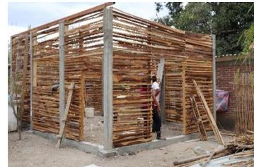
Fotografía 7. Estructuras de muros con bajareque.
