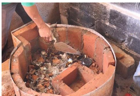
Fotografía 10. Proceso de construcción de estufa xantico.
